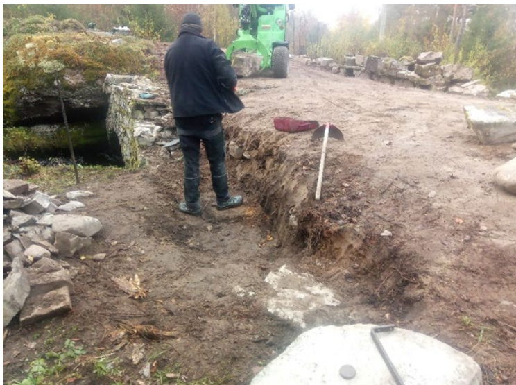
Figur 3 Etter demontering vart massar fjerna ned til ein lag av fast silt. Det fanst også restar av gamle fundamenteller og desse vart utnytta. (ein del var forvittra eller komne i ulage), Då vegkroppen innover var forsynt med ein god del steinfylling, vart dette rekna som fullnøyande masseutskifting. Foto: Haakon Aase
