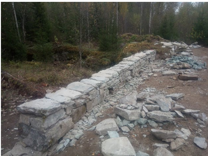
Figur 5 Parapetet (varemuren) oppstraums med dreneringshol ferdig bygd. Foto: Haakon Aase
