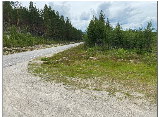
Bildet viser siktforholdene mot sør for dagens situasjon ved utkjøring på fv.2188. Oppslag av vegetasjon er til hinder for frisikten.
