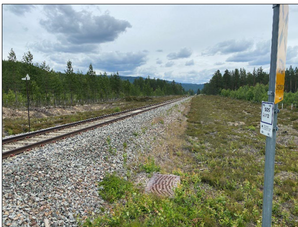
Bildet viser siktforholdene mot nord, der grusvegen inn til sandtaket krysser jernbanen.
