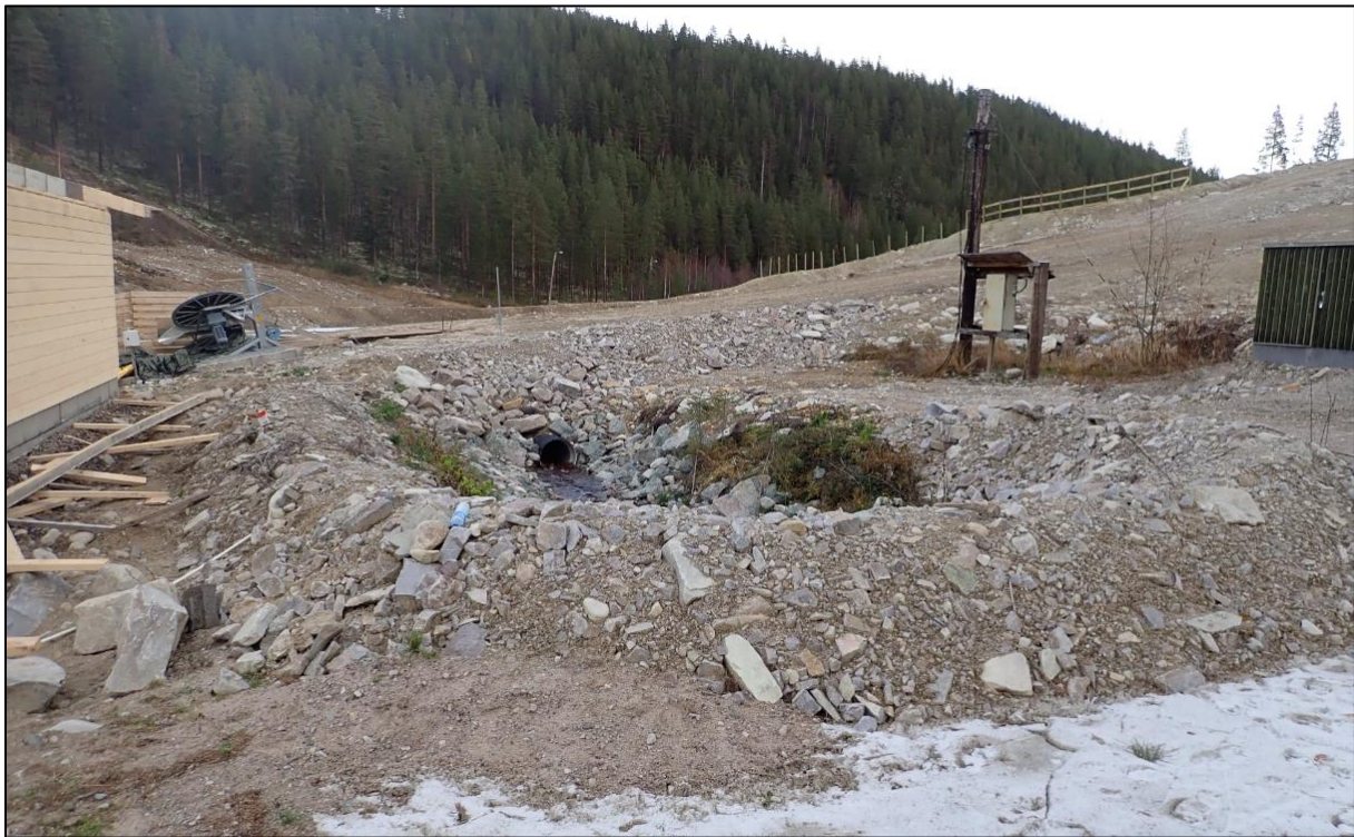
Figur 4: Bekkeløp og inntak til stikkrenne i tilknytning til skisenteret.
